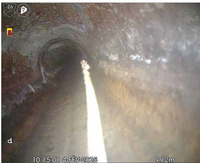
Canalisation béton
