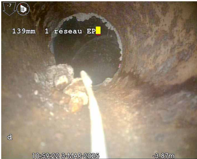
Réseau 1 (tronçon horizontal en fonte)
